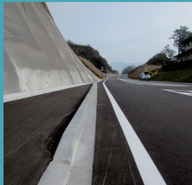
長野県 国道256号線
