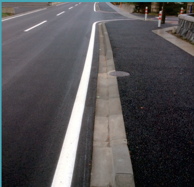
長野県 県道中堀一日市場停車場線
