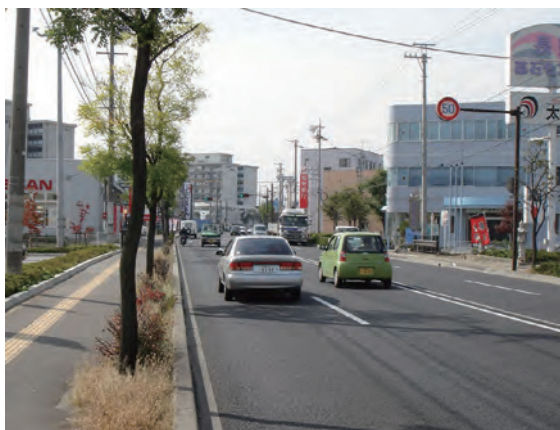
長野市(国道18号)
