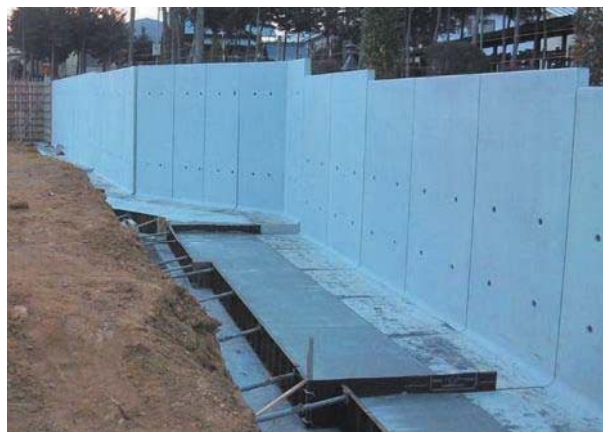
施工状況（底版部現場打ち）
