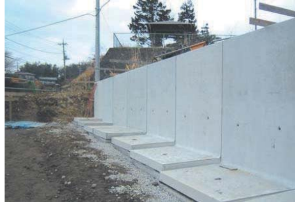
敷き段差施工
