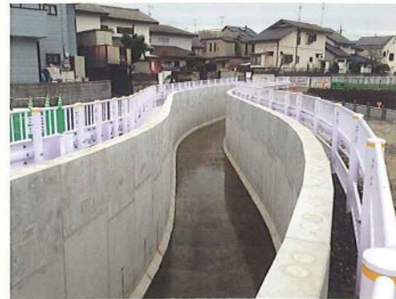
▲施工後（急曲線部 R=20m、30m）
