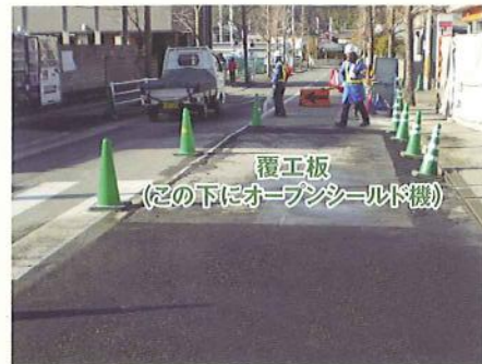
▲シールド機上を覆工し、夜間交通開放
