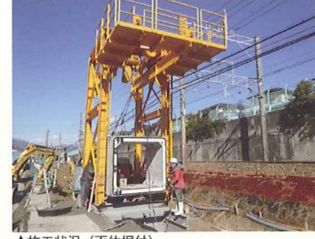
▲施工状況(函体据付)
