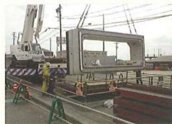
▲施工状況 (発進部より函体据付・推進)
