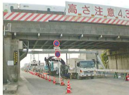
▲施工全景 (JR高架下施工状況)
