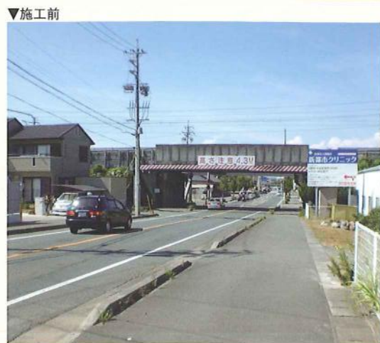
▼施工前 断面：□-4.5×1.5 延長：99m 土質：シルト質粘土 N値≒3 土被り：1.1m 地下水位：GL-0.95m
