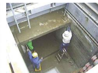
▲函体縦締用PC鋼棒緊結状況
