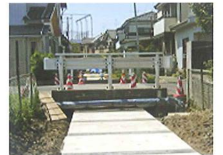
▲既設橋梁下横断
