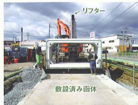
▲函体敷設状況
