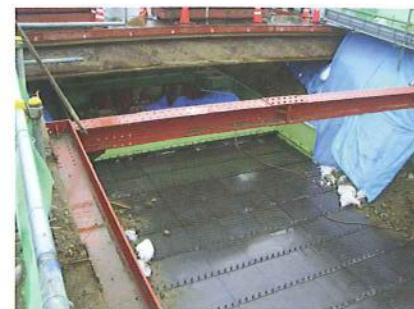
▲FCプレート設置状況
