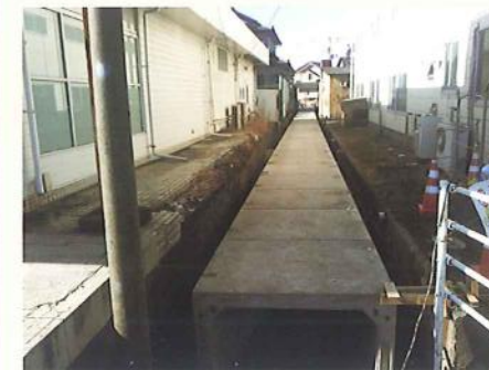
▲施工後（函体敷設完了）
