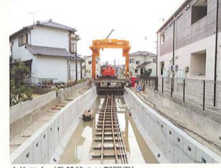
▲施工中(敷設済みU型開渠)
