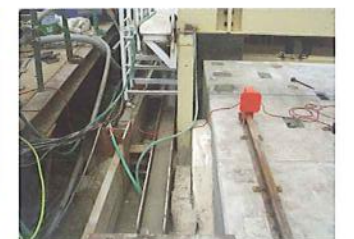
▲裏込注入状況
