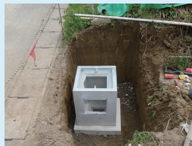
柵設置・インバートコンクリート打込み
