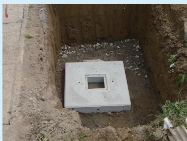
柵ベース設置
