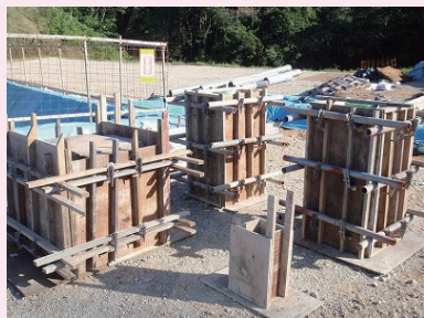
型枠組立・生コン打込み
