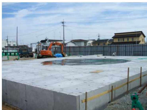
静岡県磐田市役所：磐田市総合福祉会館
