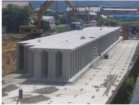
民間工事：熊本県天草市
