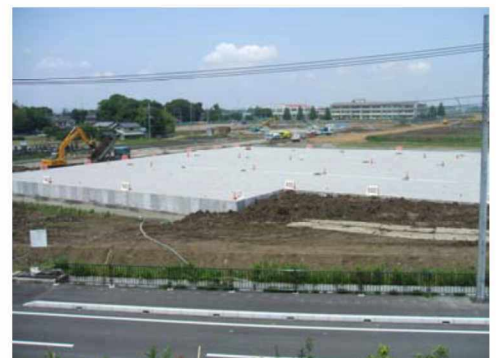
民間工事：埼玉県川島町
