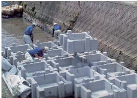
1t標準施工
