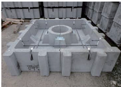
4tブロック コンクリート打込前
