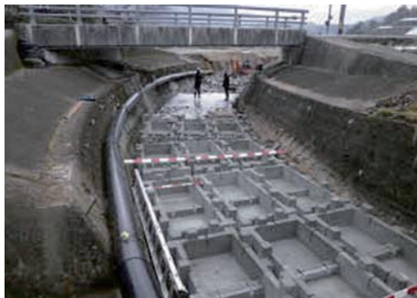
2t標準施工
