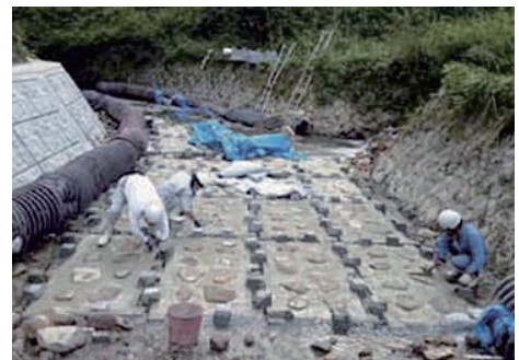
2t標準施工 植石施工
