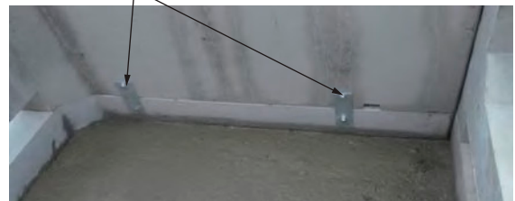
連結金具 (A・C形は、2カ所 B・C形は、1カ所取付けます。)
