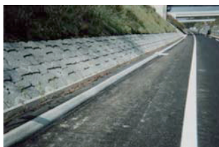
高速道路での防火帯の事例(上信越自動車道)
