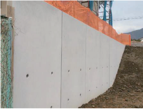
■ 逆L型擁壁 規格寸法
